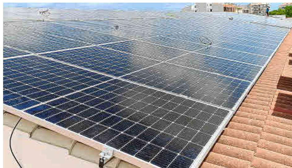
Planta de 144 placas solares con una potencia de 60KW en una nave industrial, por Domoelin.
