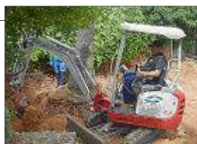
Los trabajos se centran en la parte baja del cementerio.
