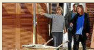
Apol·lònia Barceló relata a Armengol los daños en su vivienda.
