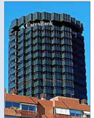
Sede central de CaixaBank en la Diagonal de Barcelona.
