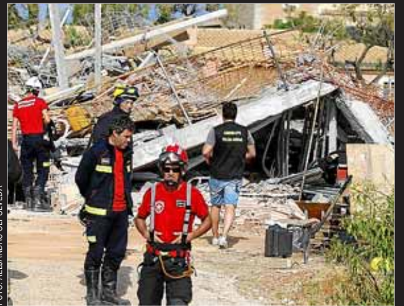
Los equipos de emergencia recuperaron el cadáver de entre los escombros producidos por el derrumbe.
