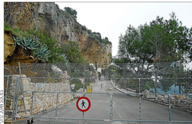
La explanada de acceso se ha hundido por la lluvia.
