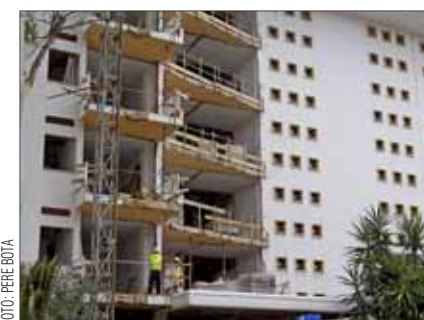
El hotel San Francisco, de la cadena Riu, es el único que está en obras.
