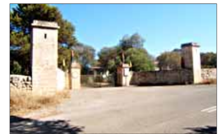
Acceso a la batería de Cala Carril.
