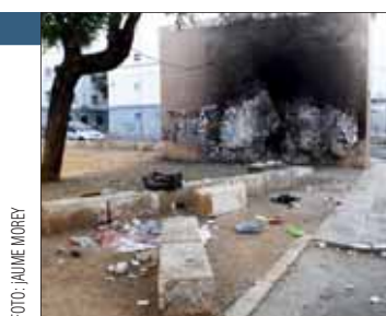
Estado actual de Camp Redó.
