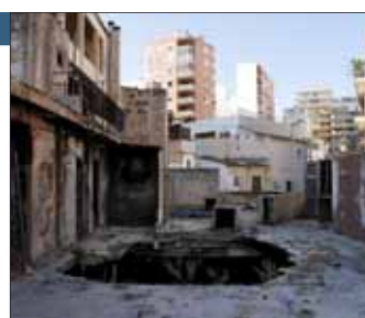
Edificio en ruinas de s'Arenal.
