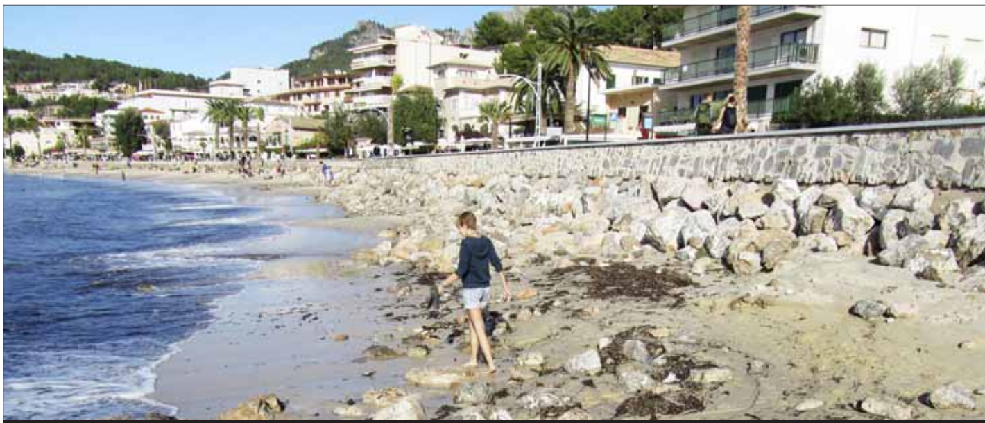
Las rocas de la playa del Través vuelven a ser visibles, tras ser cubiertas hace seis meses con arena de una cantera de Albacete.
