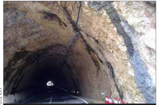
Una de las entradas del túnel del Gorg Blau.
