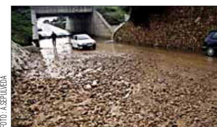
La carretera de Son Ferriol a Son Banya quedó casi intransitable.
