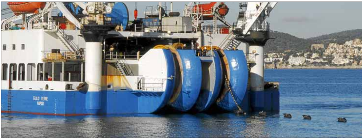
El barco 'Giulio Verne' comenzó ayer la instalación del cable, ayudado de lanchas y boyas, desde la playa de Santa Ponça.
