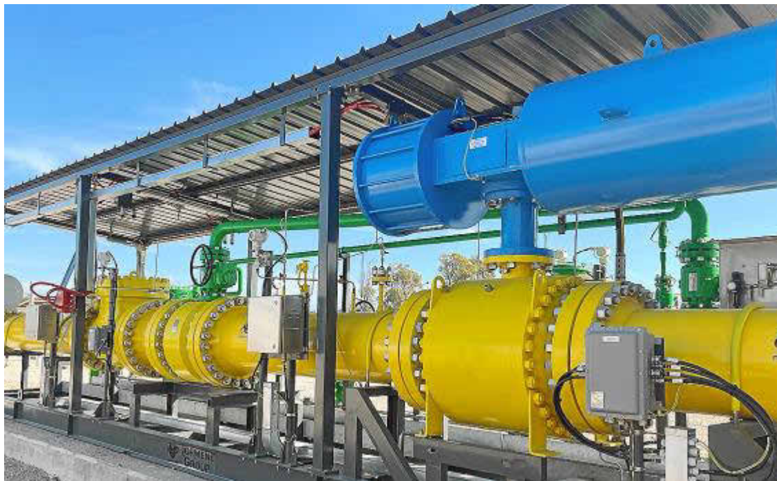
Instalaciones de 'blending' de hidrógeno verde para inyectar en la red de gas natural de Mallorca.
