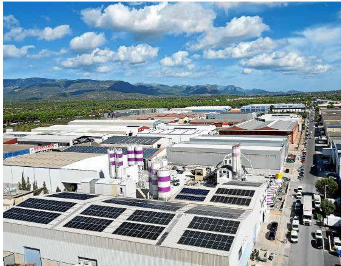
Arriba, placas fotovoltaicas instaladas en la planta de Marratxí. A la derecha, Hormort canaliza y almacena el agua de lluvia en grandes depósitos para su posterior reutilización y árido reciclado, material en línea con el compromiso sostenible de la empresa.
