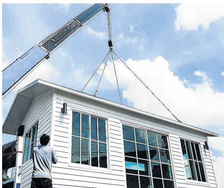
La construcción prefabricada permite confeccionar componentes en fábrica y montarlos en el lugar de la obra.
